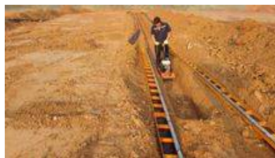
태양광 설치 지원
