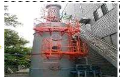
교체 후(흡수에 의한 시설)
